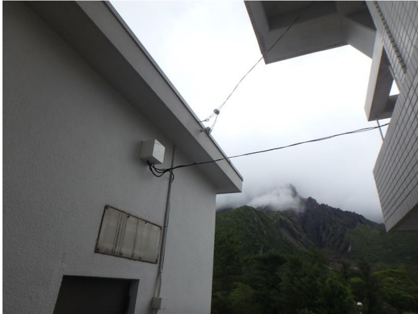
図55：観測室とA点間のケーブル引きまわし
