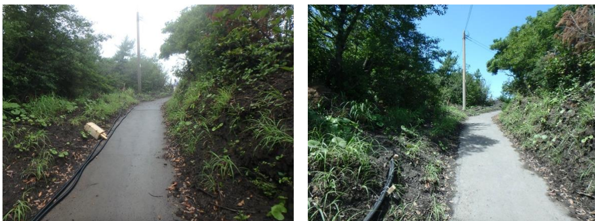
図 60 左：ケーブル埋設前 右：埋設途中
